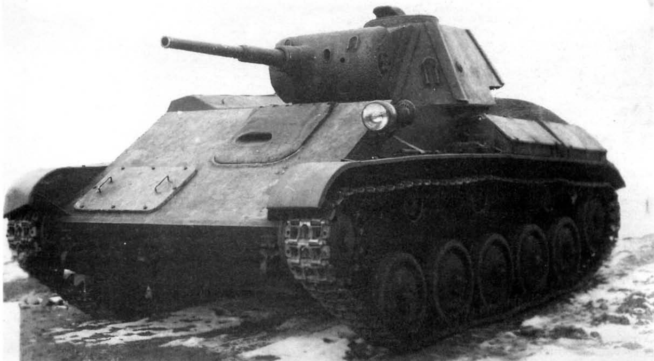
Легкий танк Т-70 выпуска Горьковского автозавода. 1942 г. (вверху). Башня и люк механика-водителя танка Т-70М крупным планом (внизу)
