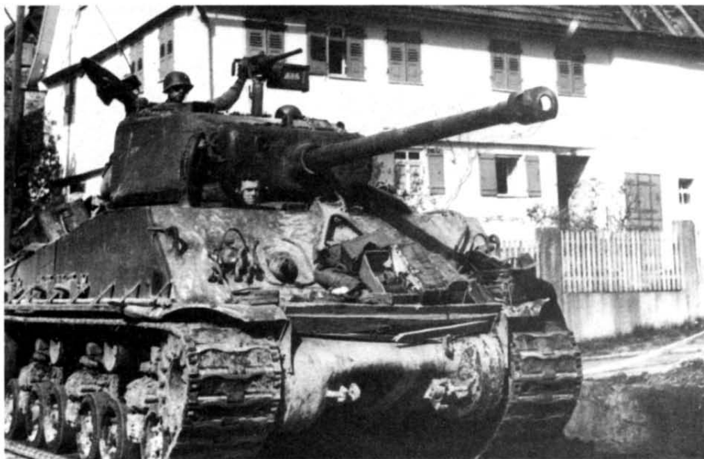
М4А3(76)W HVSS из 21-го танкового батальона 10-й танковой дивизии. Германия, апрель 1945 г. В лобовой проекции машины с горизонтальной подвеской легко было опознать по широким 23-дюймовым гусеницам
