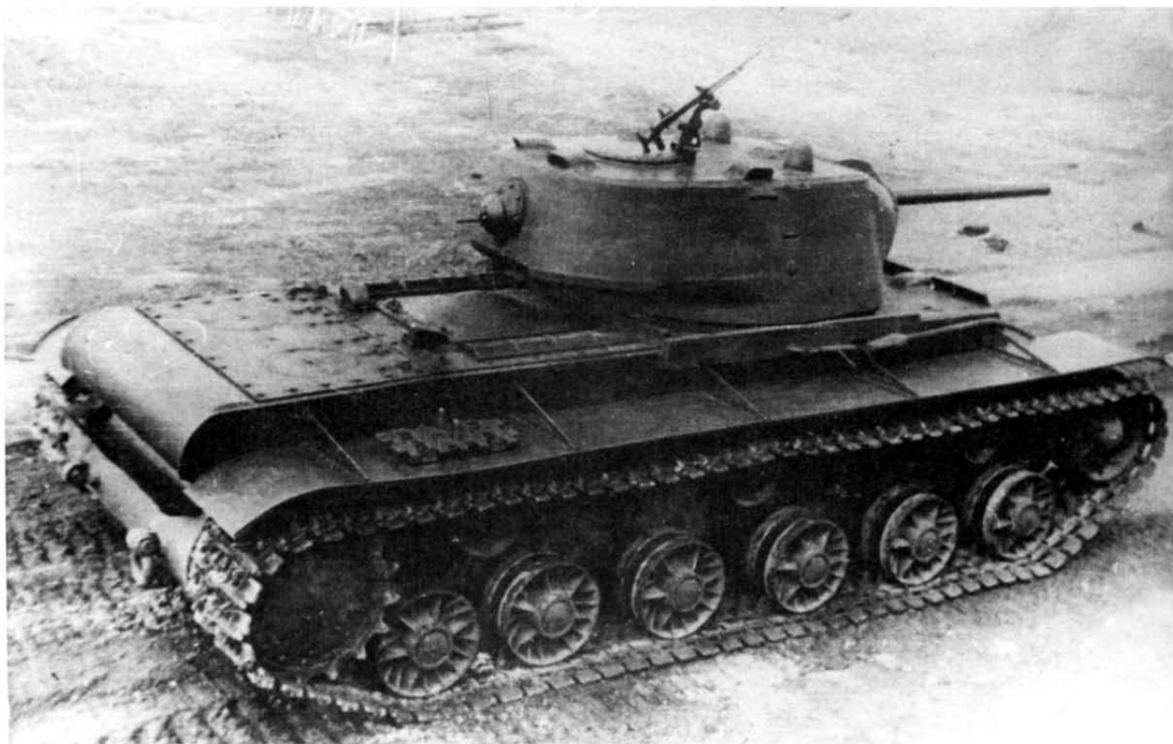
Танк KB-1 с литой башней и корпусом, выпускавшимся заводом №200. Весна 1942 г.
