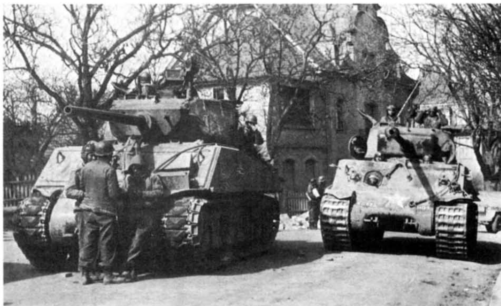
Штурмовой танк M4A3E2, перевооруженный 76-мм пушкой, из 37-го танкового батальона 4-й танковой дивизии. Германия, март 1945 г. Справа — M4A3(76)W HVSS (M4A3E8)
