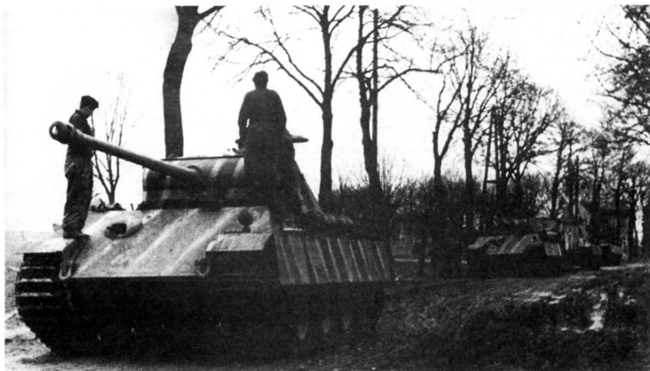
Колонна танков "Пантера" Ausf.G. Район Кюстрина, февраль 1945 г. Го- ловная "Пантера" — машина позднего выпуска, так как маска ее пушки имеет характерную "юбку" в нижней части
