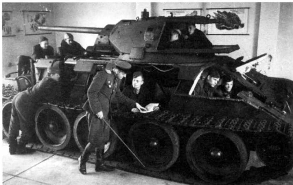
Курсанты одного из танковых училищ изучают конструкцию танка Т-34 по так называемому разрезному образцу, выполненному из танка Т-34 обр. 1941 г. производства СТЗ. 1946 г.
