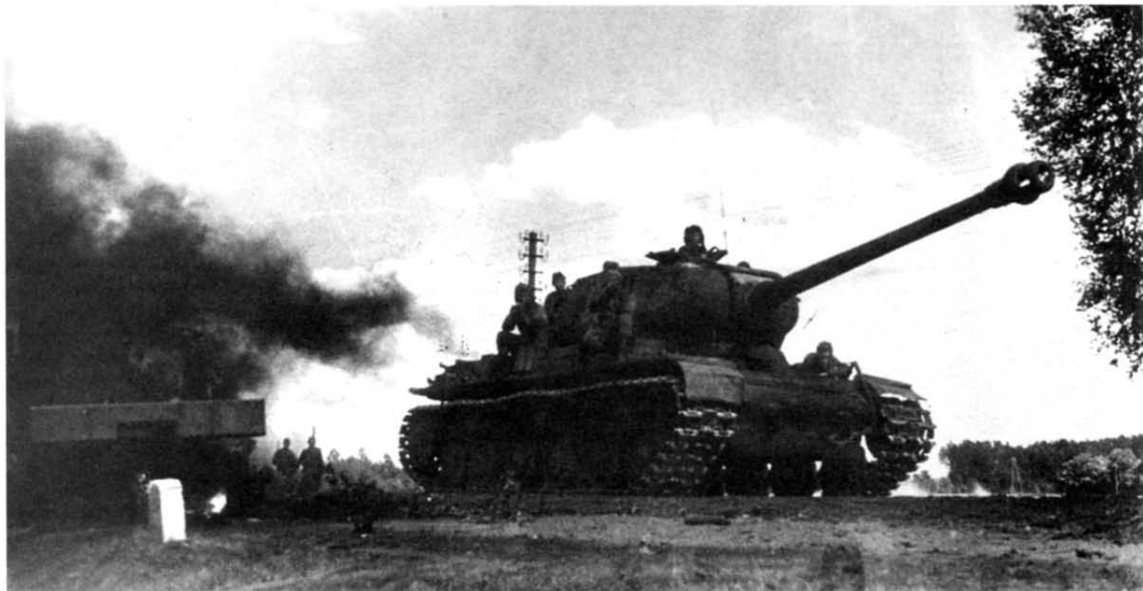
ИС-2 ранних выпусков с дульным тормозом немецкого типа. Прибалтика, лето 1944 г.
