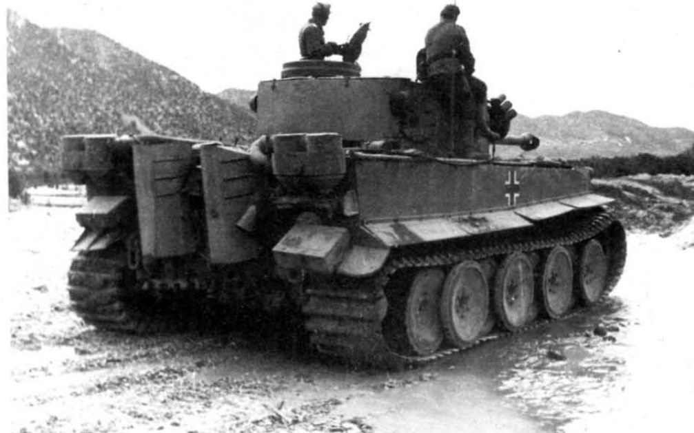
"Тигр" 501-го ба- тальона выдвигается в район боевых действий. Хорошо видны инерционные воздушные фильтры типа Feifel на кормо- вом листе корпуса. Тунис, февраль 1943 г.
