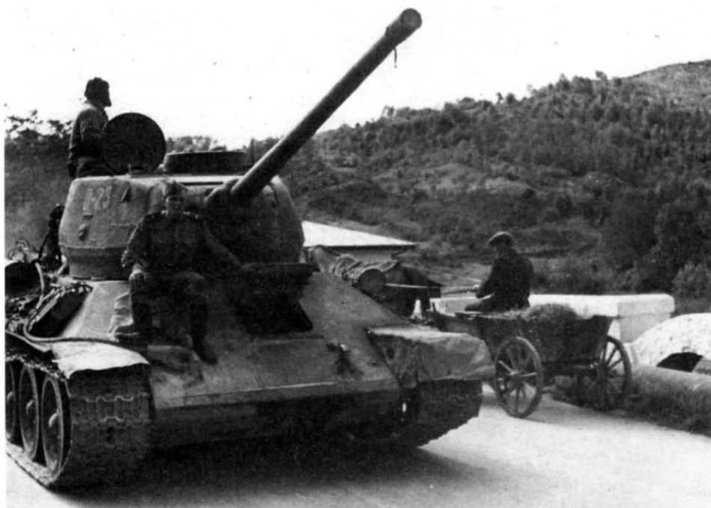
Т-34-85 ранних выпусков, о чем можно судить по пушке С-53, отсутствию бонок для крепления запасных траков на лобовой броне корпуса и приборам наблюдения МК-4 без крышечек. 2-й Украинский фронт, Румыния, лето 1944 г.
