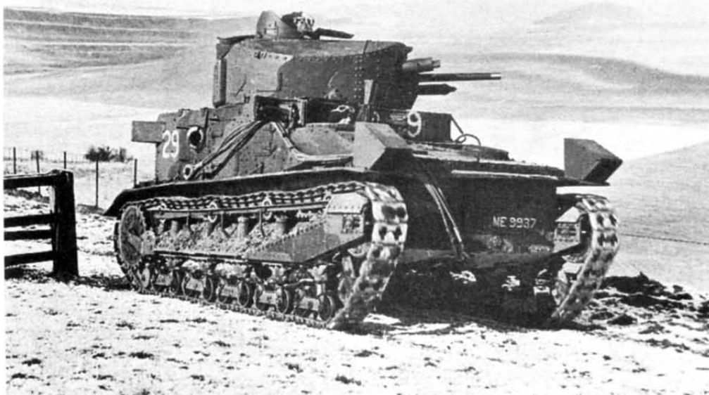
Танк Vickers Medium на позиции в Северном Йоркшире. Англия, 1940 г. Определить к какой модификации принадлежит эта машина довольно трудно. Корпус и ходовая часть соответствуют Mk IA, башня — Mk II*
