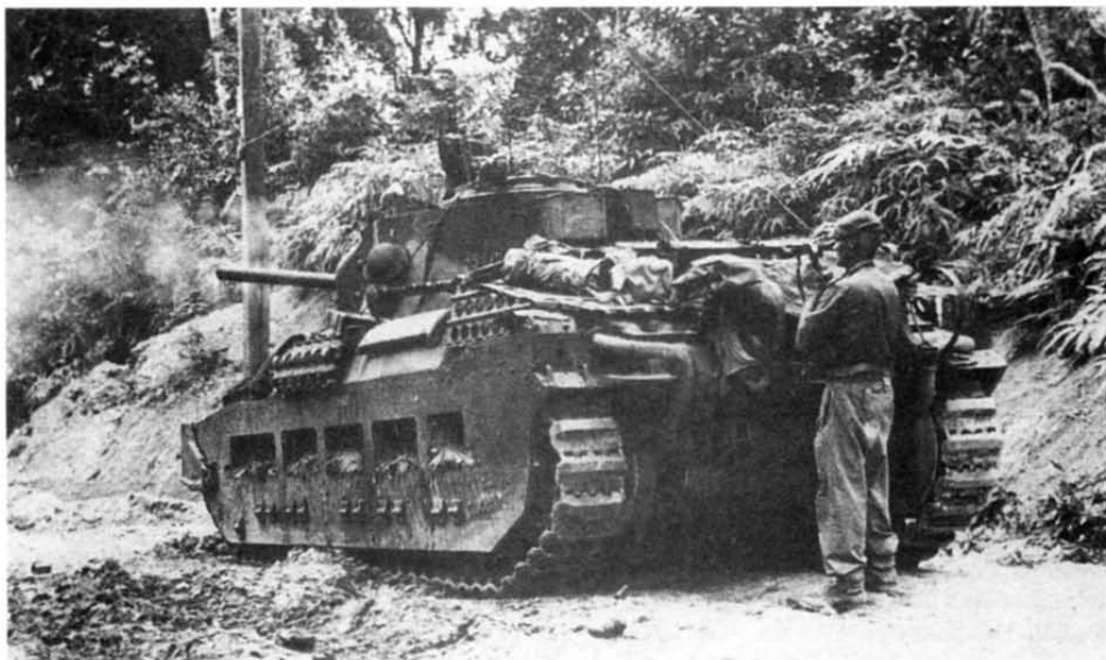
Танк огневой поддержки Matilda CS ведет огонь во время боя на острове Таракан. Пехотный офицер корректирует стрельбу, пользуясь для связи с экипажем телефоном, смонтированным на корме танка. Май 1945 г.
