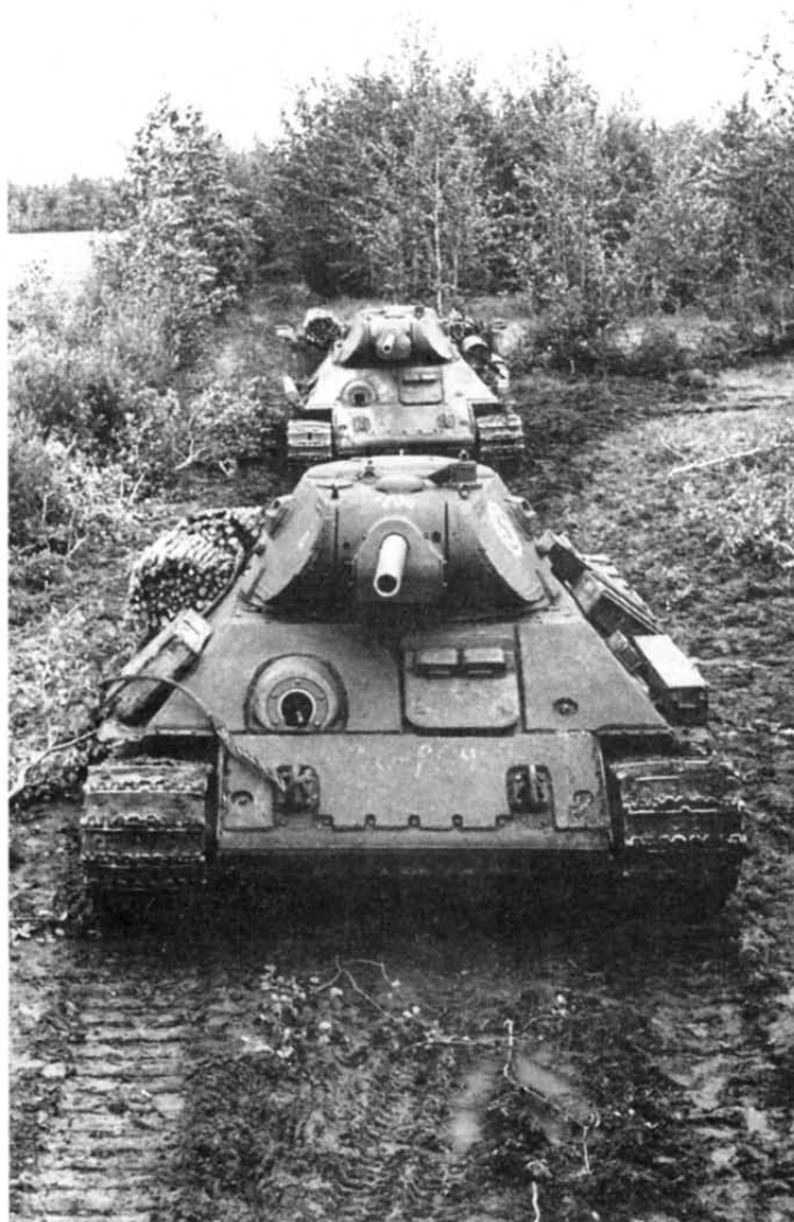
"Тридцатьчетверки", оборудованные дополнительной лобовой броней на СТЗ. Калининский фронт, 1942 г.
