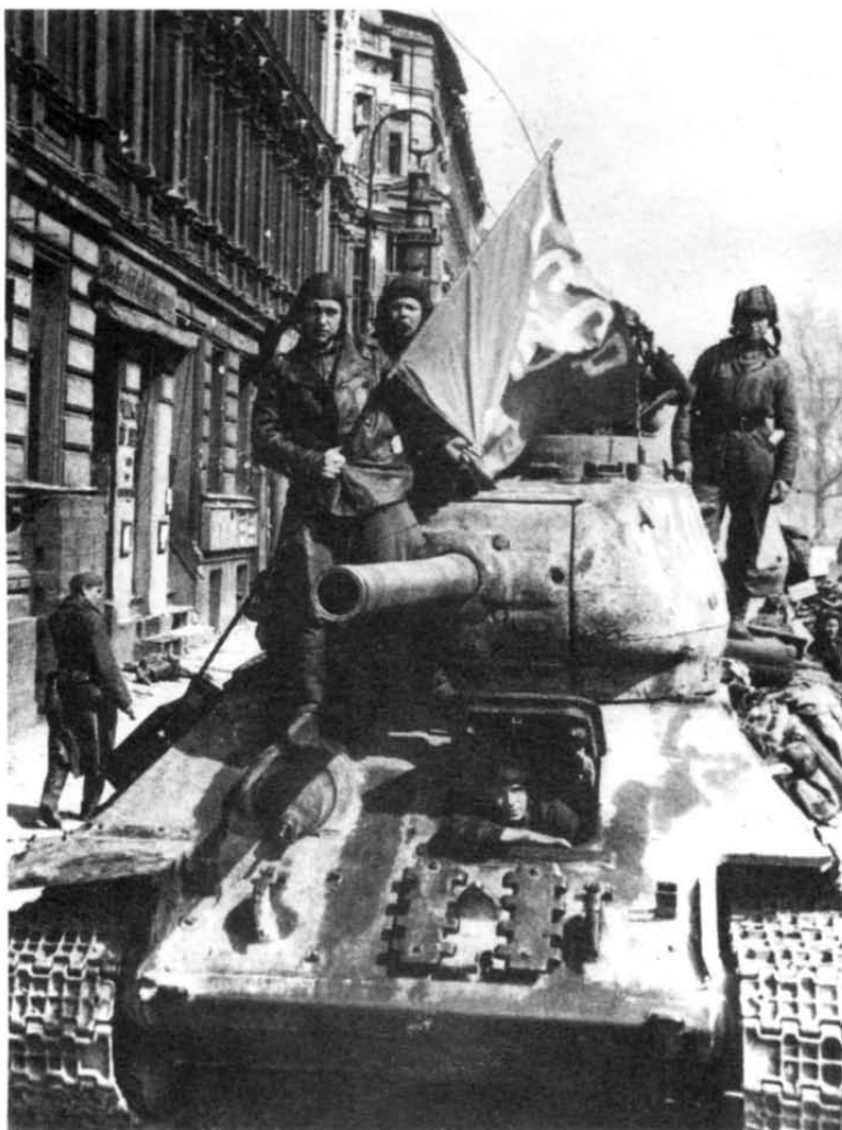
Т-34-85 в Берлине, май 1945 г. Машина поздних выпусков 1944 года с пушкой ЗИС-С-53 и креплением запасных траков на лобовой броне
