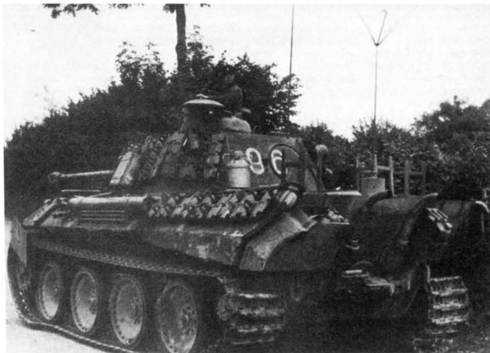
"Пантера" Ausf.G, с установленным на командирской башенке прибором ночного видения. На командирской башенке "Пантеры" смонтирован инфракрасный прожектор-осветитель мощностью 200 Вт и прибор, который позволял вести наблюдение за местностью на дистанции до 200 м
